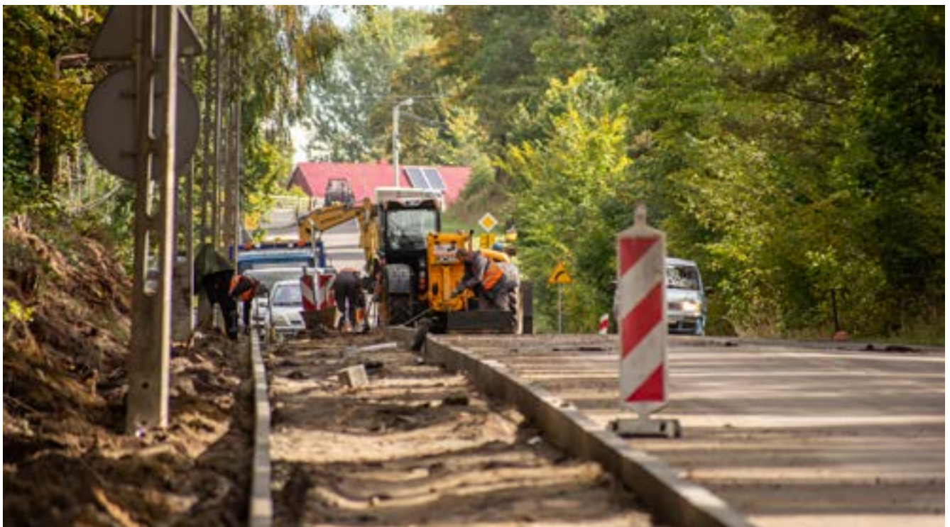
Budowa chodnika w Terespolu-Zygmuntach
