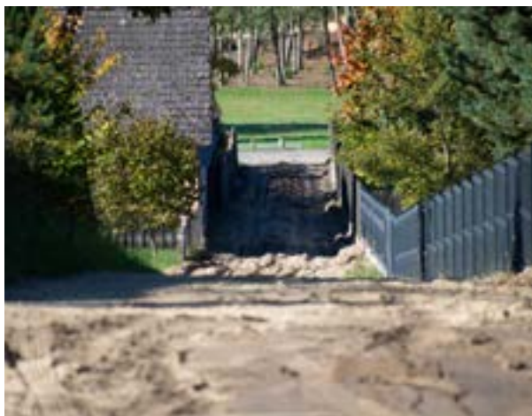
Budowa drogi gminnej w Terespolu-Kukielkach
