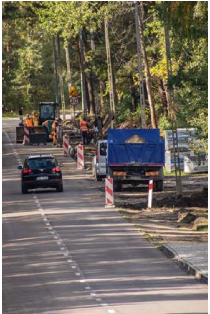
Budowa chodnika w Terespolu-Zygmuntach
