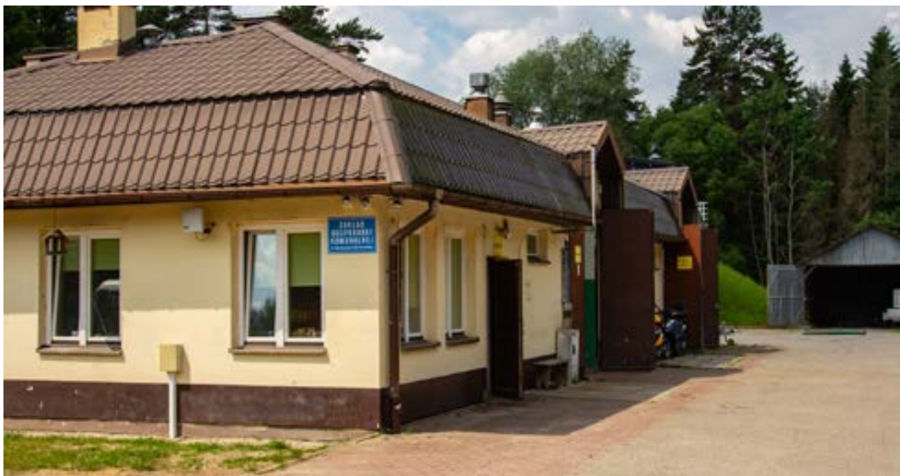
Budynek socjalno-techniczny oczyszczalni ścieków
